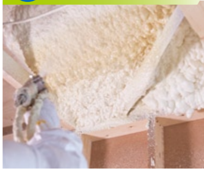
熱橋金物にも吹き付け(断熱補強)
