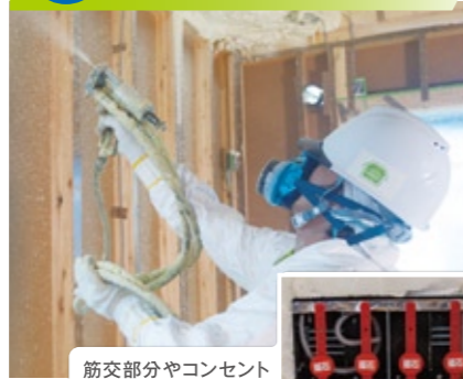
筋交部分やコンセント周りも隙間なく充填
